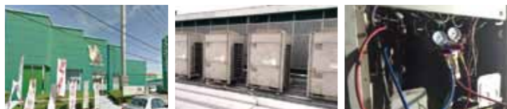
千葉県パチンコ店 2015.3 N-10に切り替え、 2店舗目も施工済み。電力は 順調に削減している。
